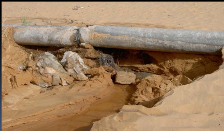
Système inadapté de répartition et de distribution de l'eau d'irrigation
